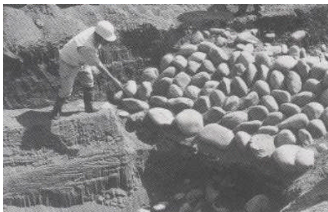
宝暦8年完成大樽川洗堰（洗堰の試掘）水うけ部
